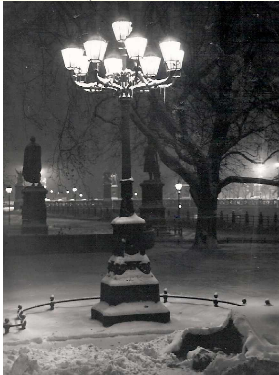
Kandelaber von Schinkel vor der Bauakademie
